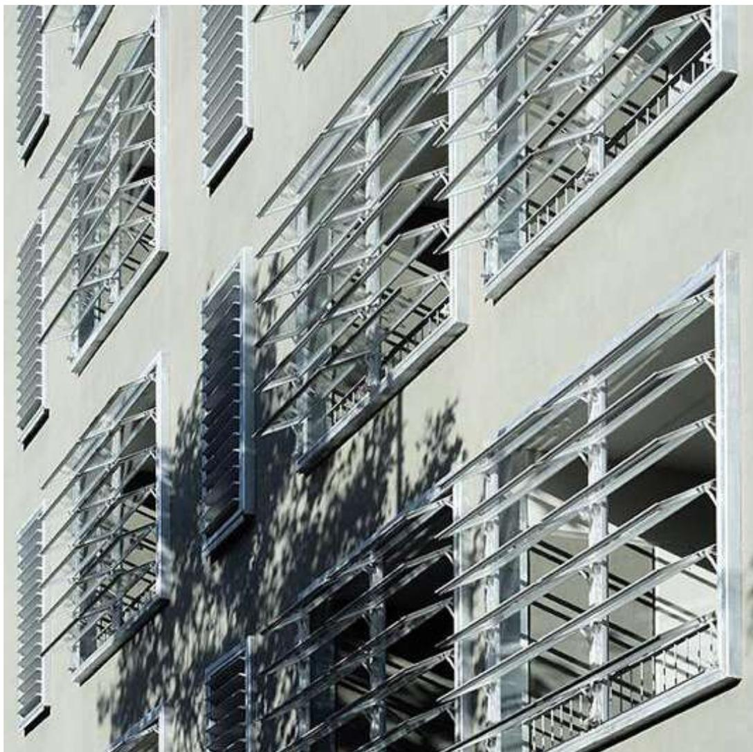
Ventana de módulos basculantes con cierre hermético, diseñada para conseguir una rápida ventilación gracias a que permite una apertura casi total de su superficie sin invadir el interior del habitáculo.
